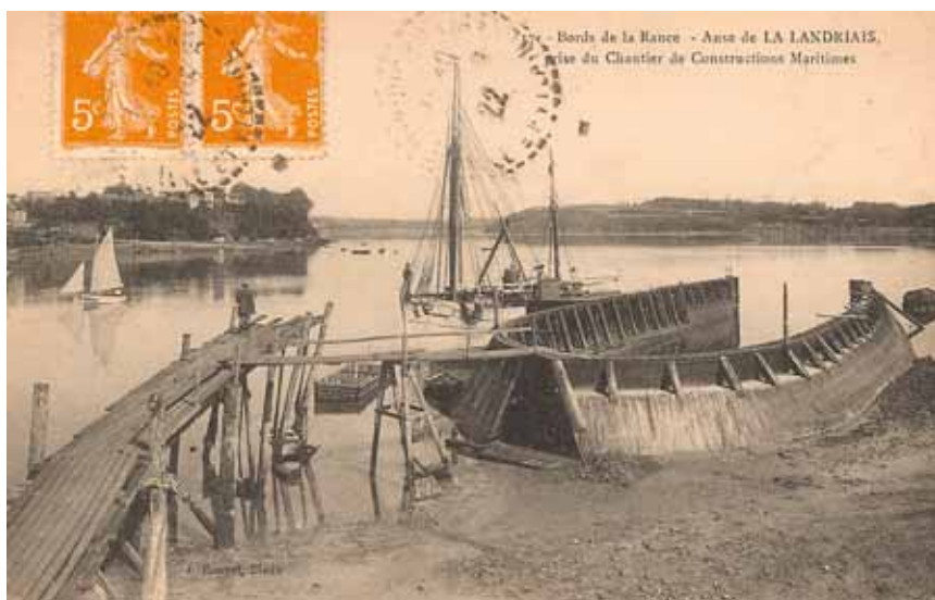
Figures 1 et 2 – Chantiers de constructions maritimes de La Landriais (cl. Archives départementales d'Ille-et-Vilaine, tous droits réservés)
