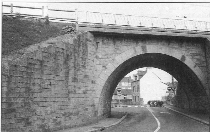
Figure 10. – Pont-biais, sous la voie ferrée Paris-Brest, rue Saint-Lazare. Large emploi du granite de Saint-Brieuc.
