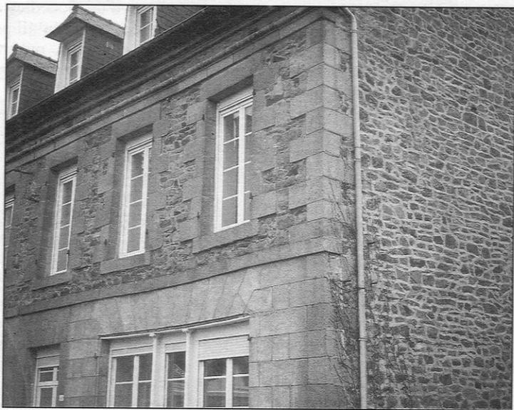
Figure 8. – Rue Saint-Lazare. Rez-de-chaussée, chaîne d'angle, encadrements des ouvertures et bandeau, en pierres de taille façonnées dans le granite de Saint-Brieuc. Pignon en petits moellons d'orthogneiss local.
