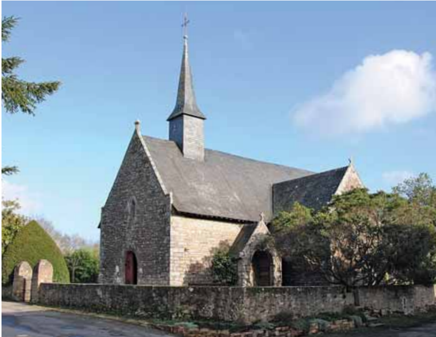
Figure 1 – Sautron, chapelle Notre-Dame de Bongarant, vue du côté sud-ouest (cl. F. Déan)
