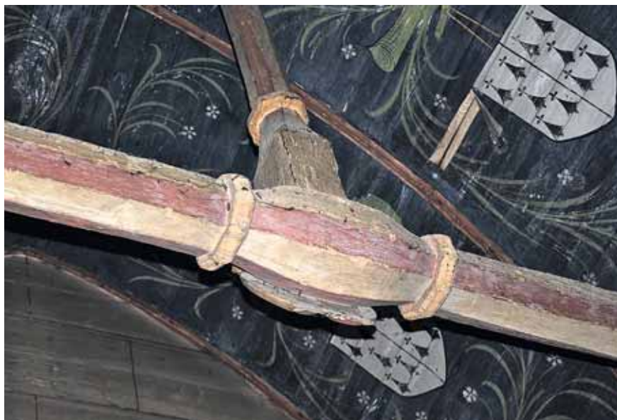
Figure 3 – Sautron, chapelle Notre-Dame de Bongarant, bagues ornant entrait et poinçon à leur jonction (cl. F. Déan)
