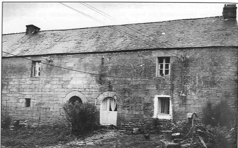
Figure 6. – Langoëlan. Guerntarer. Logis étable à deux portes, avec étage, milieu XVII<sup>e</sup> siècle. Les fonctions combinées sont ici superposées.
