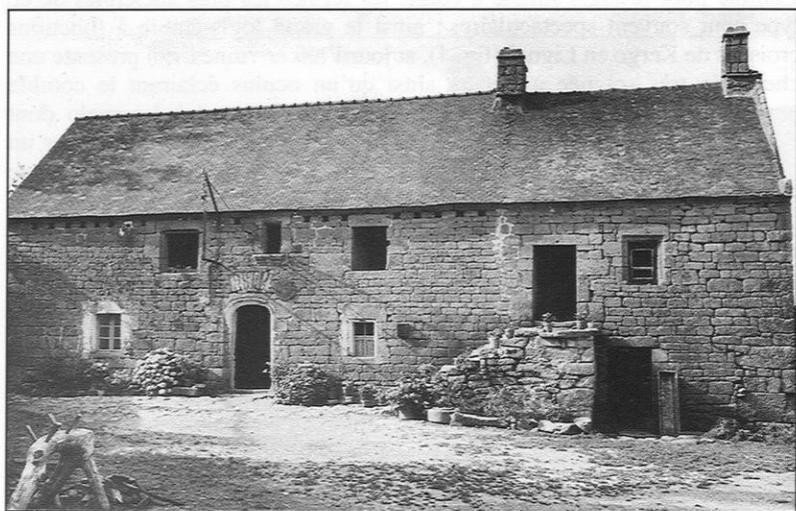
Figure 5. – Langoëlan. Taléros. Ferme à fonctions combinées à distribution croisée, fin XVI<sup>e</sup> siècle. La chambre haute, accessible par l'escalier extérieur, surmonte l'étable.
