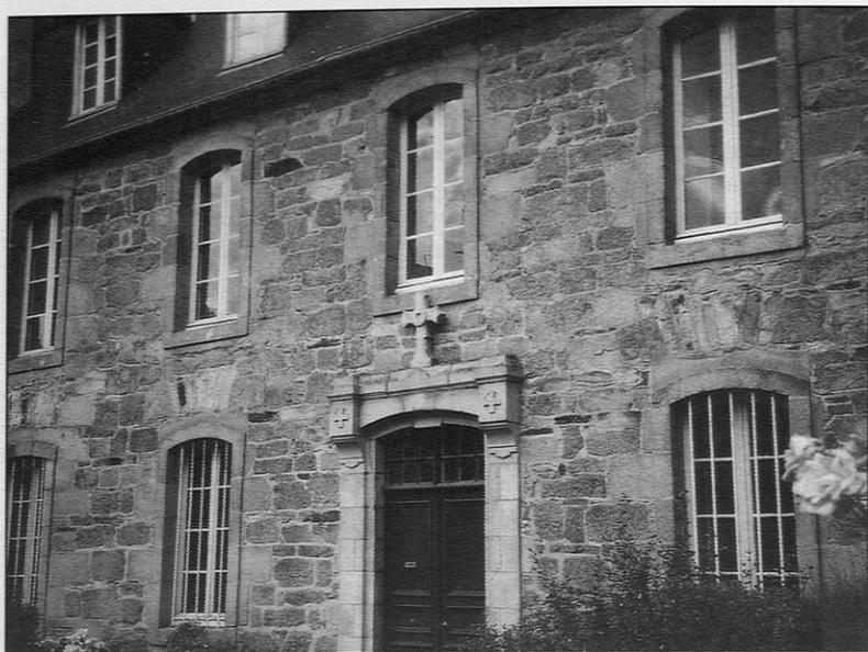
Couvent des Augustines. Polyolithisme. Moellons de l'élévation en granite du Yaudet. Pierres de taille de l'entrée en granite blanc de l'île Grande. Arcs de décharge en schistes tuffacés.
