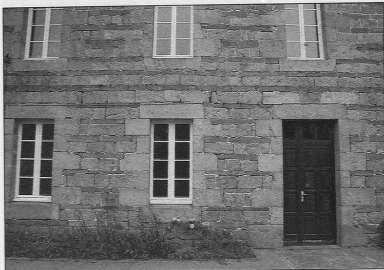
Demeure à proximité de la chapelle Saint-Joseph. Elévation présentant une alternance régulière de schiste tuffacé et de granite. Encadrement des ouvertures en pierres de l'Ile Grande.
