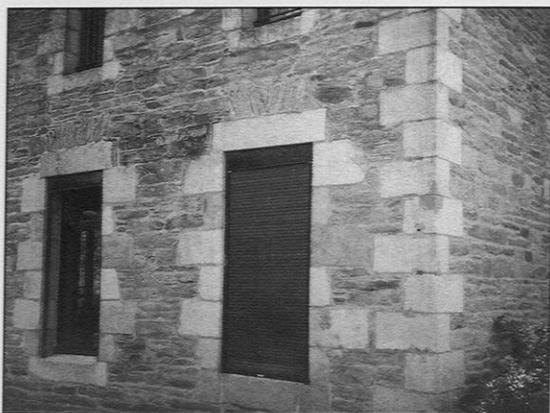
Couvent des Ursulines. Chaînage d'angle et entourage des ouvertures en granite blanc de l'Ile Grande. Murs en moellons de schistes tuffacés gris-verdâtre.
