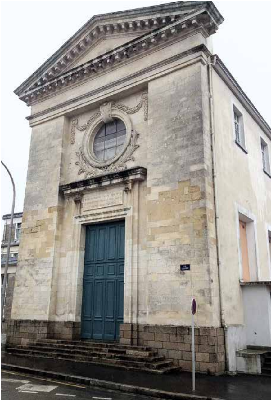
Figure 8 – Chapelle de l'hôpital, façade actuelle
