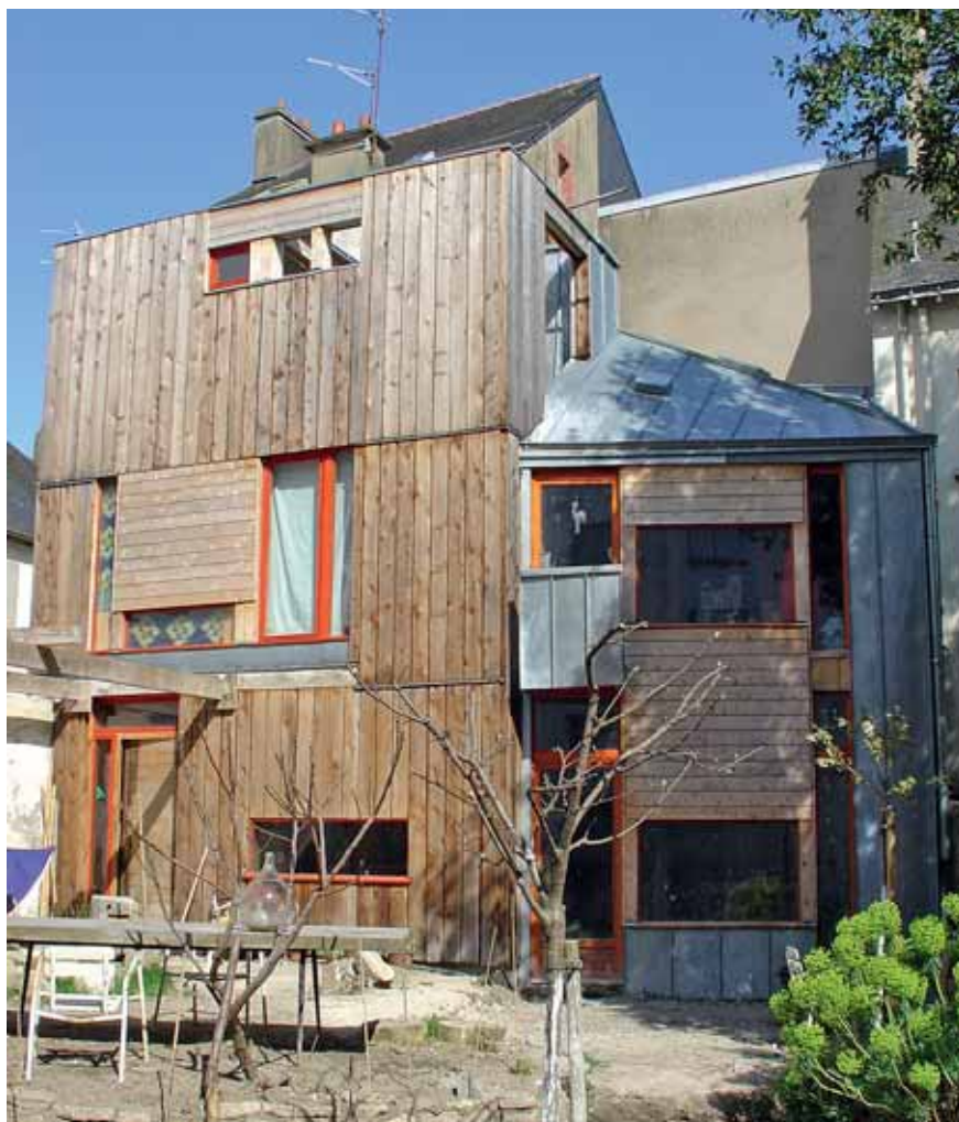
Figure 12 – Maison individuelle, Vannes, Sébastien Chauchat et Emmanuelle Millet, PAB 2004
