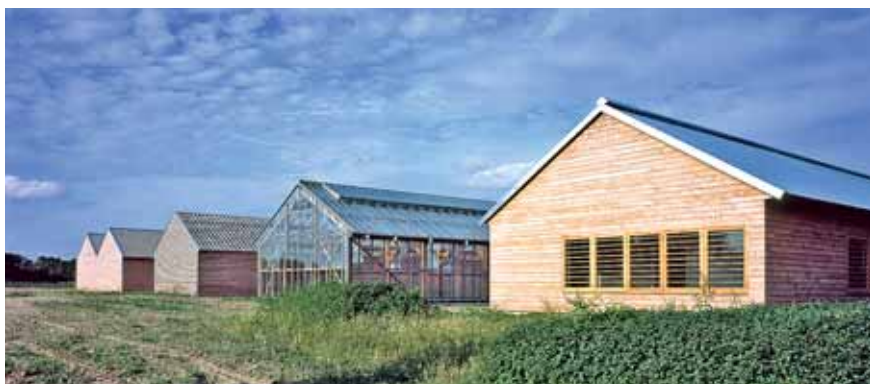
Figure 8 – Locaux techniques et administratifs du domaine de La Roche-Jagu, Ploëzal, David Cras et Bruno Le Pourveur, PAB 2004
