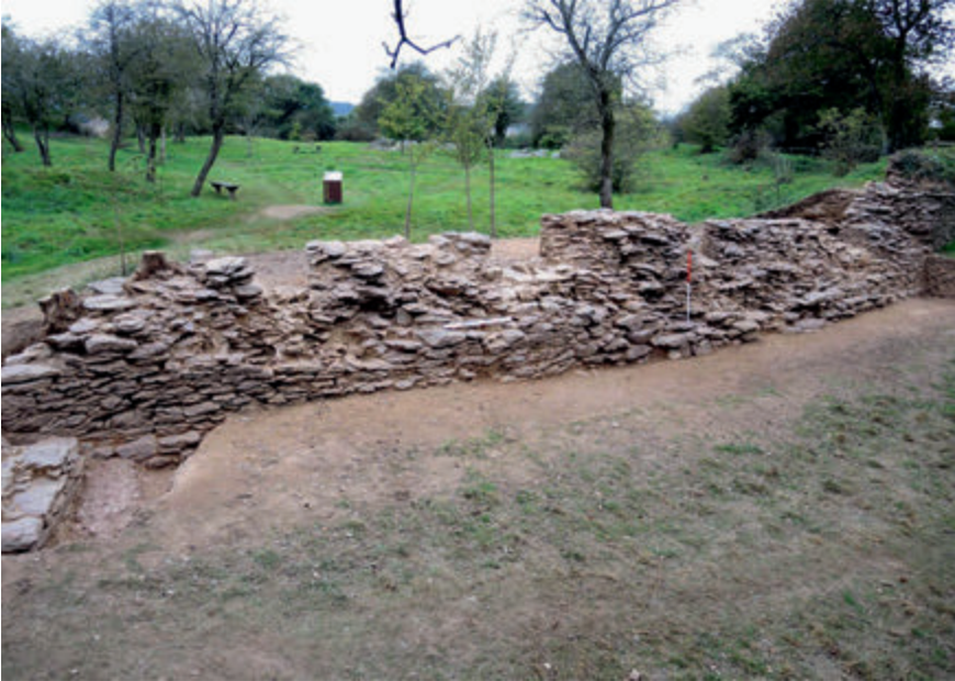
Figure 5 – Le mur de couraine nord-est avec ses ouvertures et l'arrachement des pierres (cl. CERAPAR)
