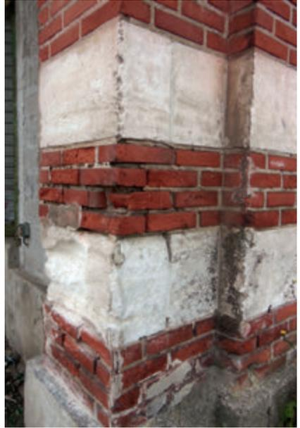
Figure 27 – Un des bâtiments de la gare, alternance brique rouge – tuffeau blanc (altéré) (cl. L. Chauris)
