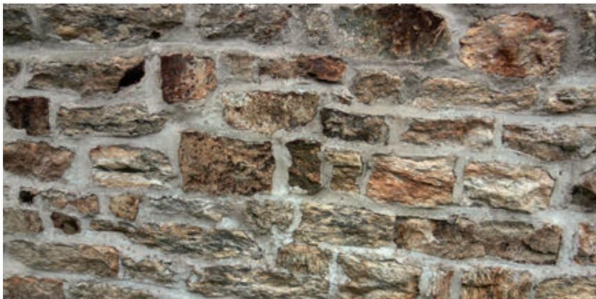
Figure 3 – Près des Ursulines, orthogneiss, dans un mur, en moellons plats, hétérométriques. (cl. L. Chauris)
