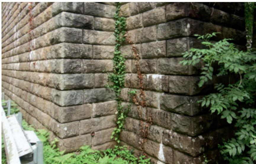
Figure 18 – Une des piles du viaduc sur la Laïta, granite gris du Scorff (chaînage d'angle) et leucogranite (en moellons assisés) (cl. L. Chauris)
