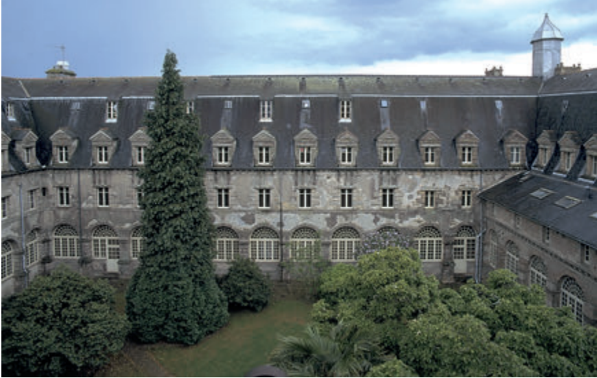
Figure 2 – Le bâtiment du dortoir (1710-1725) et la cour du cloître vus du nord-est (Service de l'Inventaire du Patrimoine Culturel © Région Bretagne) (cl. Bernard Bègne)
