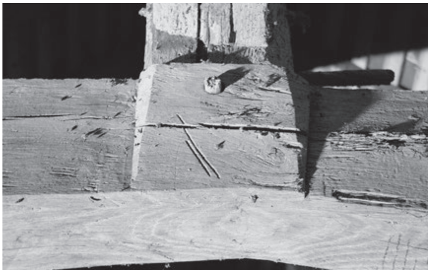
Figure 1 – Acigné (Ille-et-Vilaine), manoir de La Havardière, Marquage « II » fait à la rainette, déformation due à une fente de séchage (© cl. C. Olivier)
