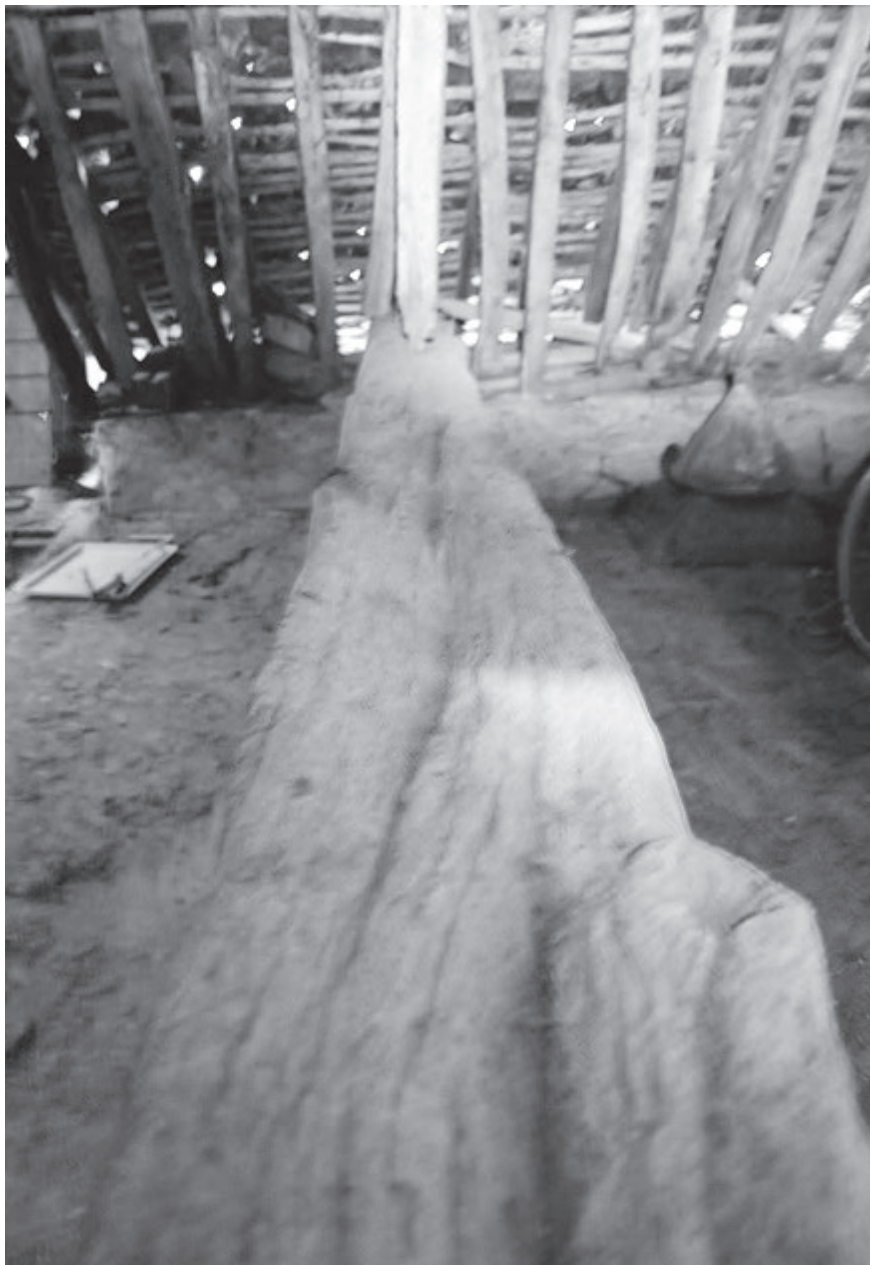
Figure 3 – Comblessac (Ille-et-Vilaine), manoir de Porcaro, entrait réalisé dans un bois d'émonde (© cl. C. Olivier)
