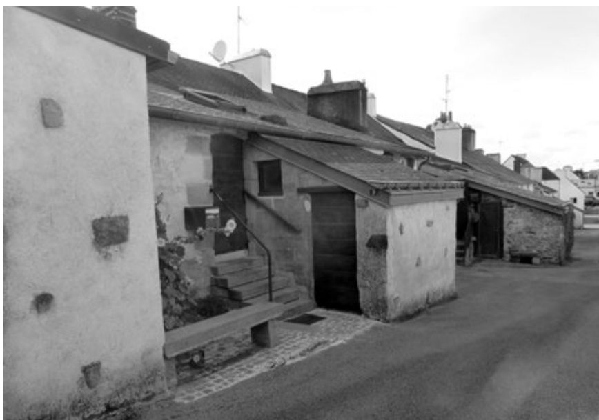
Figure 6 – Aspect actuel de l'arrière des maisons ouvrières, rue de la Surveillante (cl. A. Penneç)
