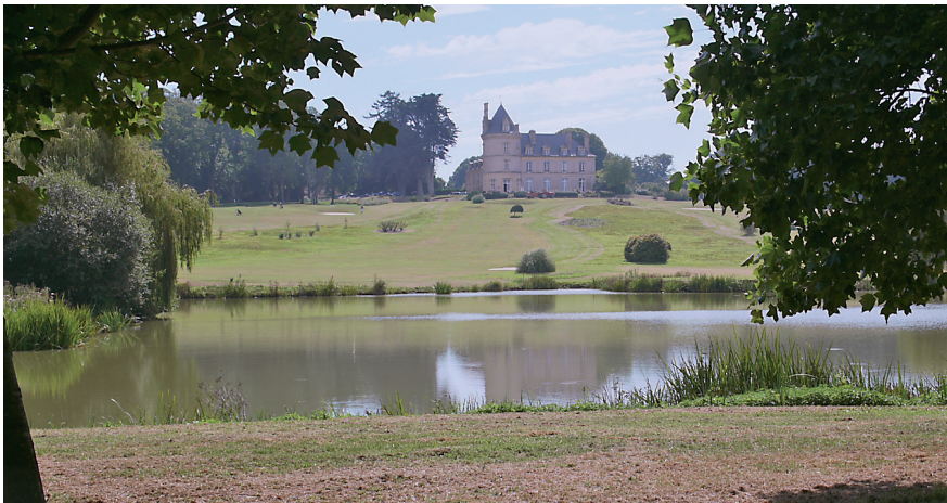
Figure 1 – Le château moderne de Boisgelin, construit vers 1840, vu du nord. Au premier plan le nouvel étang qui date de la création du golf, achevé en 1982 (cl. G. Meirion-Jones, 15 septembre 2012)
