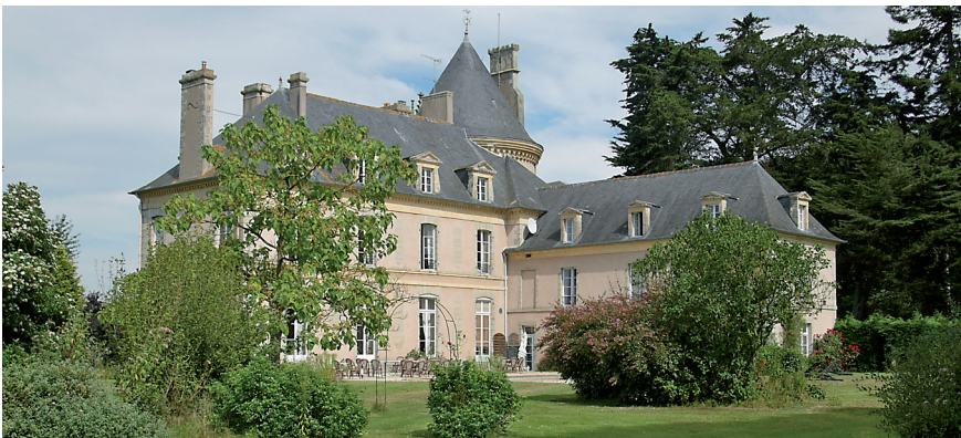
Figure 10 – Le château moderne de Boisgelin construit vers 1840, montrant les phases de construction (cl. G. Meirion-Jones, 15 septembre 2012)
