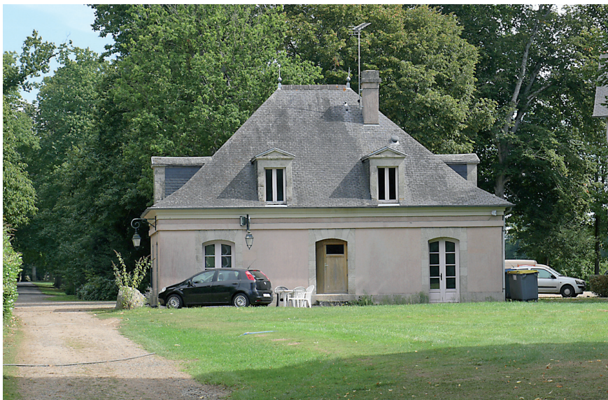
Figure 11 – La conciergerie du château moderne, construit vers 1840 (cl. G. Meirion-Jones, 15 septembre 2012)
