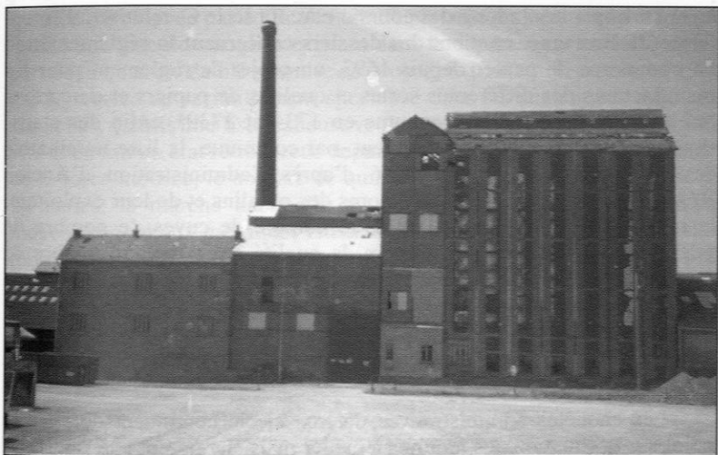
Vue générale sud-ouest de l'usine d'acide sulfurique Delplace, à Dol-de-Bretagne. Du haut de ses 38 m, la cheminée est l'une des plus hautes du département.
