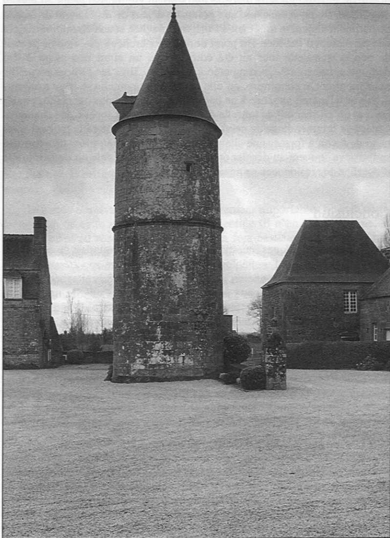
Figure 3 : La tour : élévation sud (cliché Gwyn Meirion-Jones)
