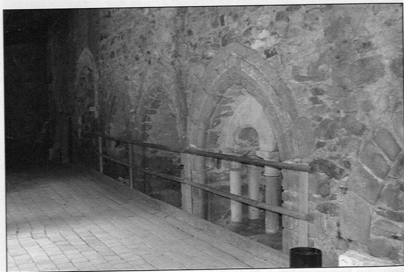
La salle capitulaire vue du préau (état en 2008).
