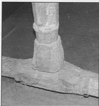
Figure 16 – La Hélarrière : la base du poinçon, dont la fonction est de supporter le milieu du tirant (le tirant, ou entrain, destiné à être vu d'en bas, est léger et finement sculpté ; ce n'est nullement une poutre porteuse). Les poutres porteuses, qui supportent le plancher actuel, ont été insérées, probablement au début du seizième siècle, en dessous des tirants d'origine.
