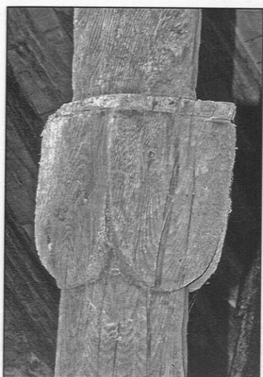
Figure 14 – La Hélarrière : la charpente de la salle basse. Le poinçon de la première ferme, près de l'entrée, porte, gravés dans le bois, quatre écus qui ont dû porter des armoiries peintes à l'origine.
