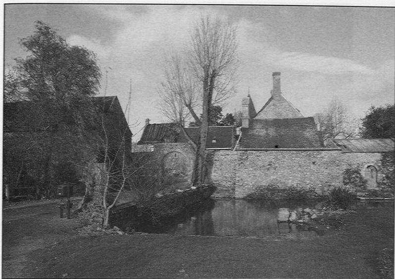
Figure 7 – Vue d'ensemble. À noter : les bâtiments de la métairie à gauche de l'entrée, l'ancienne salle basse en face et le logis actuel à droite. La chapelle, à côté de l'entrée, est effectivement en appentis.
