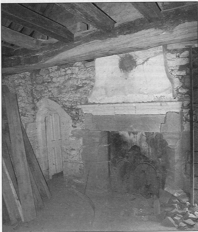
Figure 22 – La Héliardière : la chambre au fond de l'aile est, à l'angle nord-est de l'ensemble. A noter, la cheminée de la fin du seizième siècle, date probable de cette construction. La porte à gauche conduit à la latrine.
