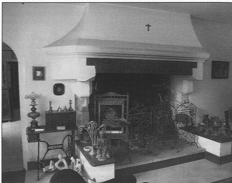
Figure 19 – La Hélaridière : la grande cheminée, probablement du quatorzième siècle, de l'ancien chamber-block (fig. 10). Elle a été restaurée au moins une fois et le linteau de pierre d'origine a été remplacé par un linteau de bois.
