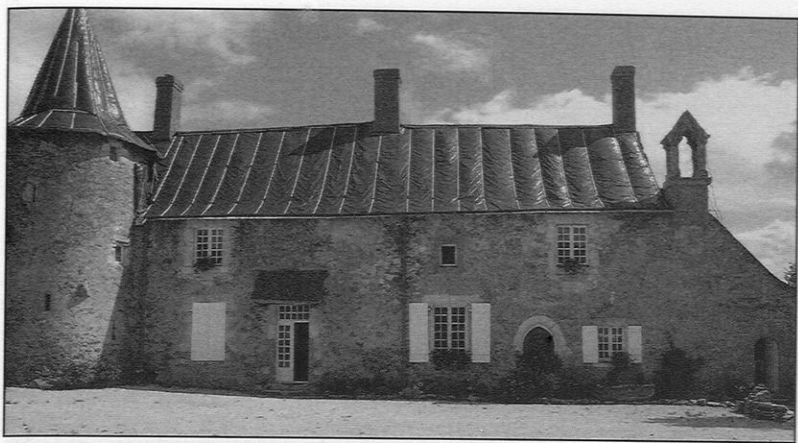
Figure 17 – La Hélarrière : l'aile est du manoir, vue de la cour. À gauche, la grande tourelle d'escalier qui relie le corps principal, contenant la salle basse, et cette aile «résidentielle» dont la partie droite semble être du quatorzième siècle et qui, à cette époque, constituait un chamber-block . Ce dernier fut relié au corps principal par la campagne de construction du début du seizième siècle. La chapelle, datant probablement du seizième siècle dans son état actuel, a été rajoutée à la construction antérieure. Cliché : Gwyn Meirion-Jones, le 06.09.2005.
