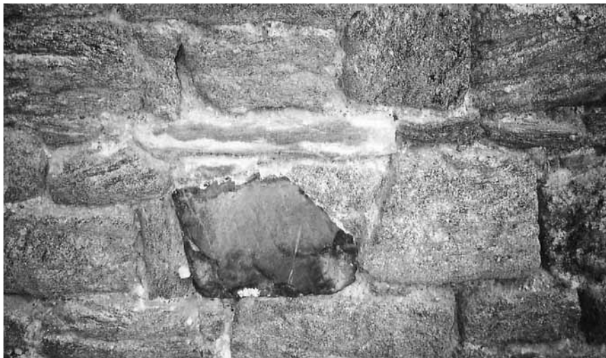
Figure 8 – Courtine ouest du château (XIV e siècle). Moellons hétérométriques de migmatites brunâtres, assemblés de façon aléatoire, au centre, dolérite vert sombre, surmontée par un moellon allongé de clair platin (cl. L. Chauris)
