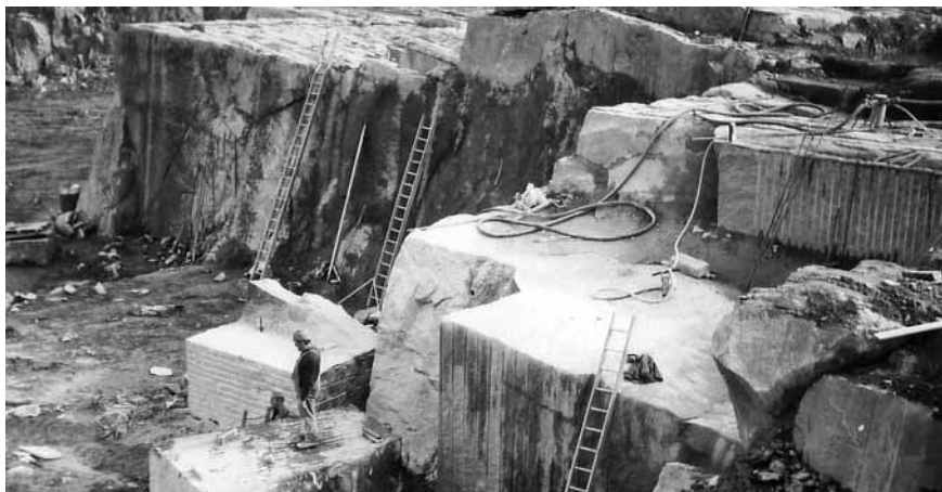
Figure 6 – Vue partielle d'une des carrières ouvertes dans le granite bleu de Lanhélin (entreprise Hignard), énormes masses débitées au moyen de trous de perforation (cl. L. Chauris)
