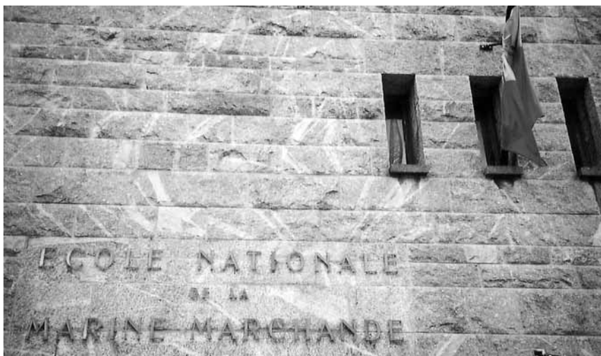
Figure 12 – Les innombrables filonnets d'aplite recoupant le granite de Brusvily apparaissent comme autant de balafres sur les élévations de l'École nationale de la Marine marchande (cl. L. Chauris)
