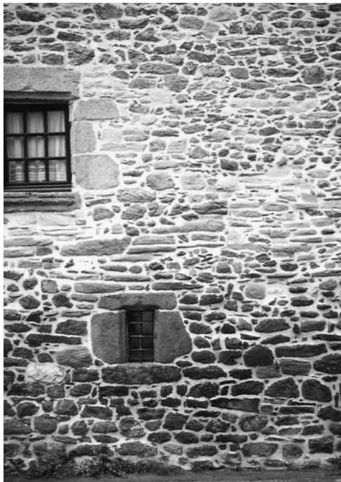
Figure 13 – Maison ancienne à Saint-Servan, association aléatoire des moellons en migmatite, platin, dolérite et quartz filonien (cl. L. Chauris)
