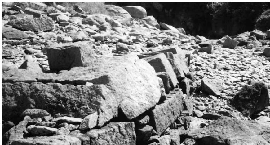
Figure 4 – À Chausey, à proximité de la carrière du Gros-Mont, quai ruiné d'embarquement du granite (cl. L. Chauris)
