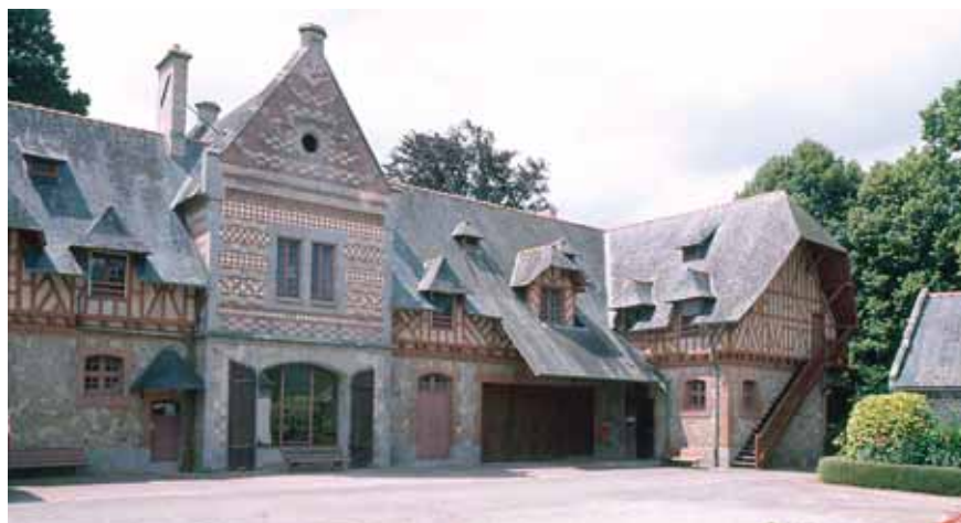
Figure 16 – Vue générale des communs (cl. Guy Artur, Inventaire, Région Bretagne)
