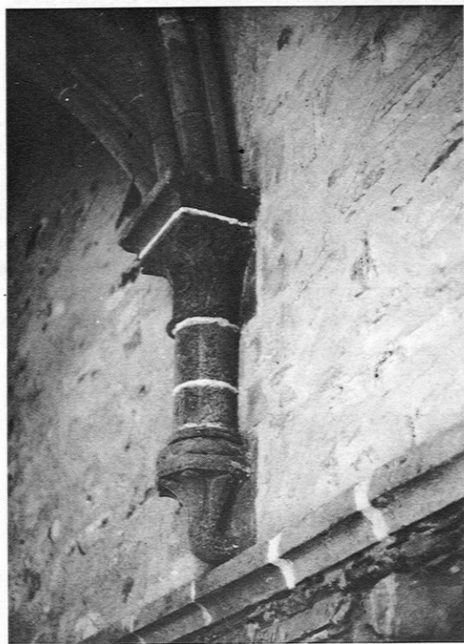
Fig. 1. — Bâtiment des hôtes : culots coulés des retombées de voûtes d'ogives.
