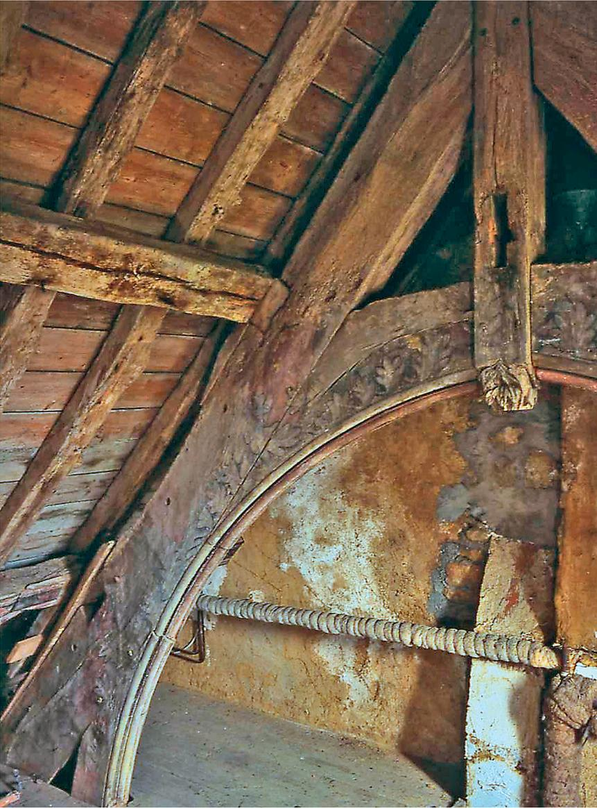
Figure 11 – Éléments de la charpente de l'ancienne charpente apparente de la salle haute (Arch. dép. Ille-et-Vilaine, fonds Meirion-Jones, 1<sup>er</sup> juillet 1994)
