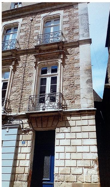
Figure 18 – Vannes, près de la Porte-Prison, rez-de-chaussée d’une maison en tuffeau, en voie d’altération (cl. M.-M. Chauris)
