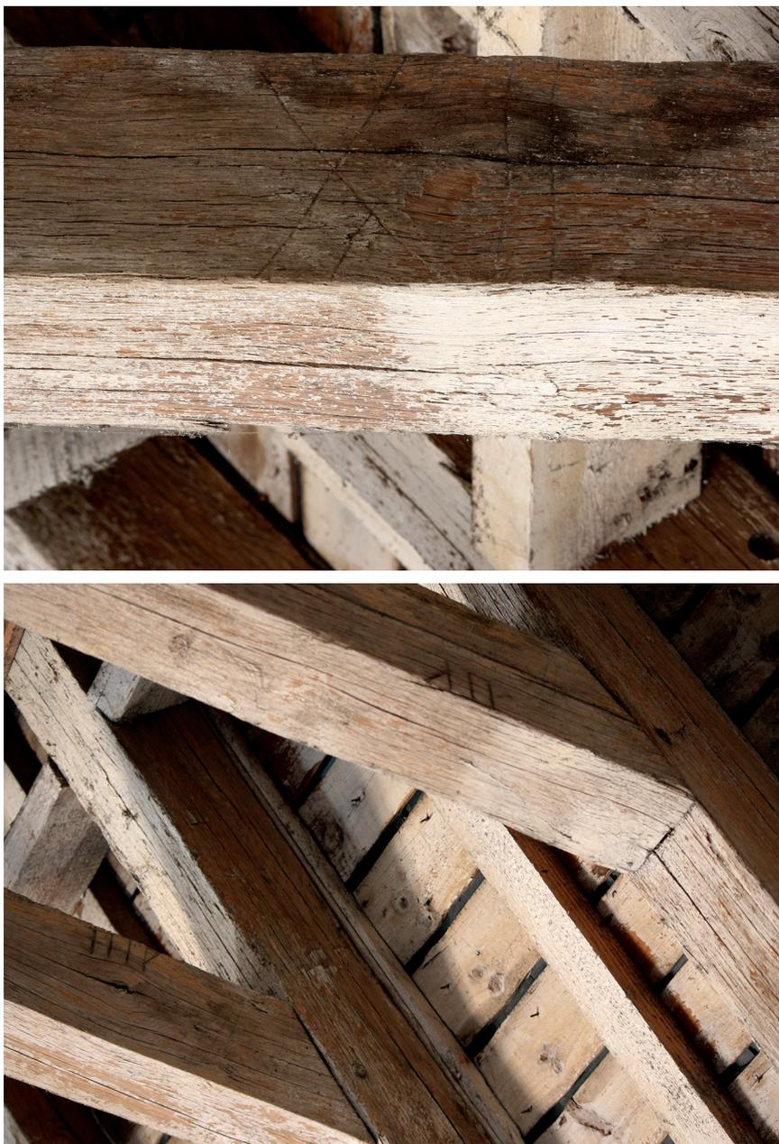
Figure 19 – En haut, marquage 12 à la rainette, charpente de l'aile ouest ; en bas, marquage 3 et 4 au ciseau avec contremarque, aile ouest (cl. C. Olivier – CÉRAM)
