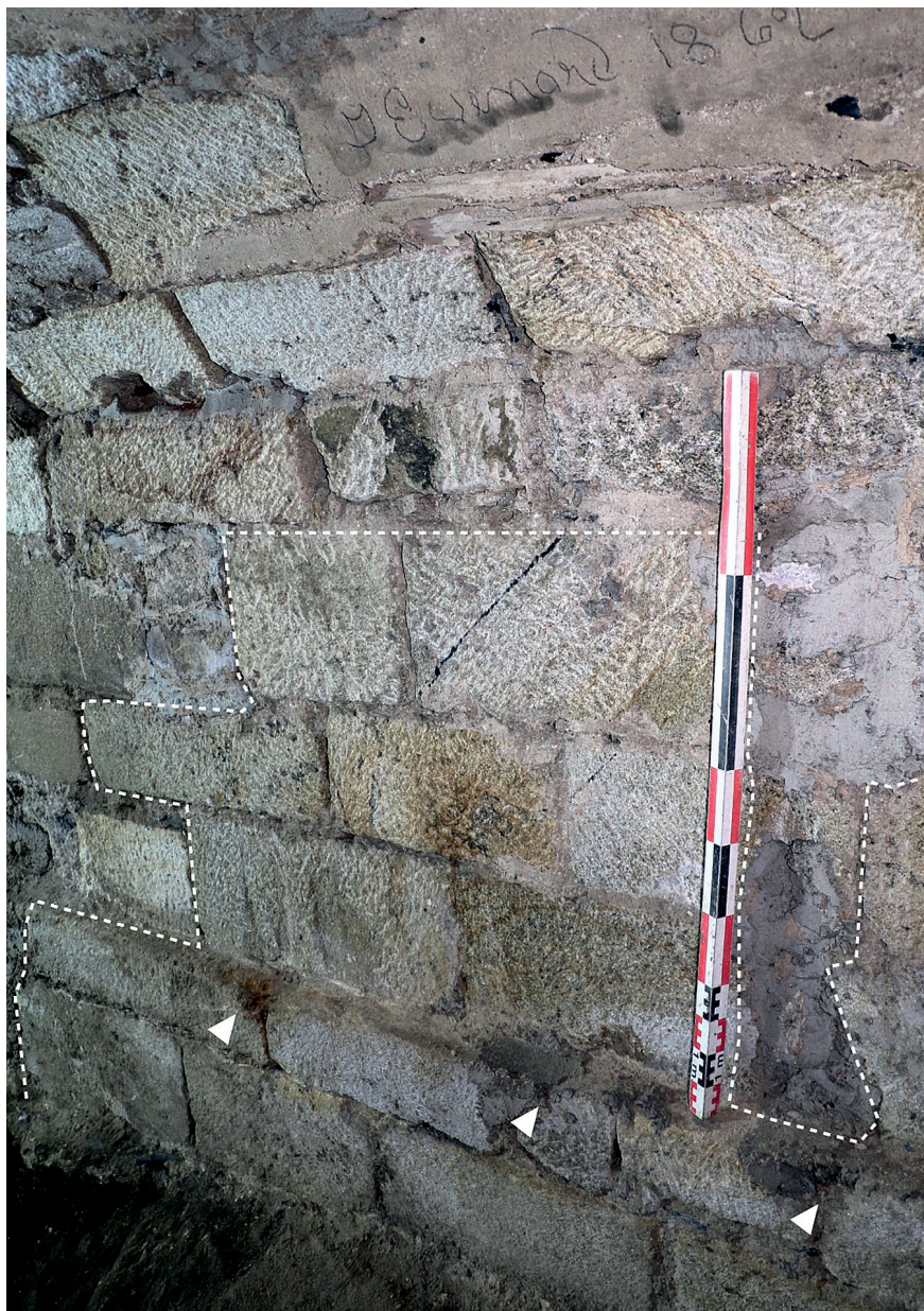
Figure 3 – Vannes, cathédrale, crypte, paroi nord du pourrissoir (cl. S. Daré – CÉRAM) Au-dessus des pointillés, les maçonneries reprises. Les triangles blancs signalent les encoches qui recevaient les barres transversales en fer.
