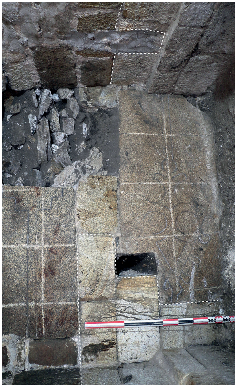
Figure 4 – Vannes, cathédrale, crypte, partie orientale du pourrissoir (cl. S. Daré – CÉRAM) Au-dessus des pointillés, les maçonneries reprises. On notera les deux dalles funéraires en remploi dans le mur est.
