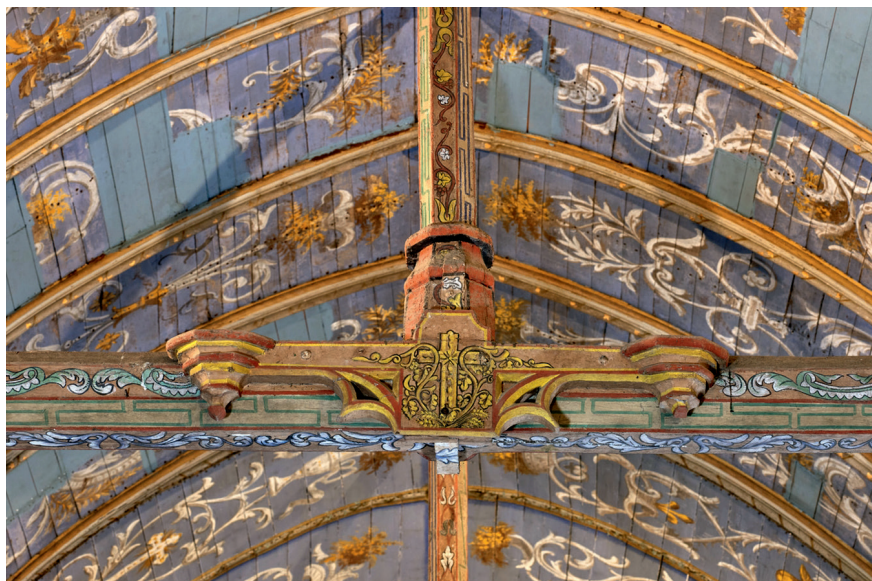
Figure 24 – Le Quillio, église : ancienne traverse de la poutre de gloire remontée sur un entrain de la charpente du chœur (cl. Bernard Bègne, Inventaire du patrimoine culturel © Région Bretagne)
