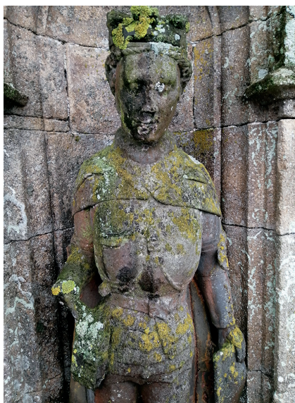
Figure 9 – Corlay, église, façade ouest, statue de saint Salomon (cl. C. Jablonski)
