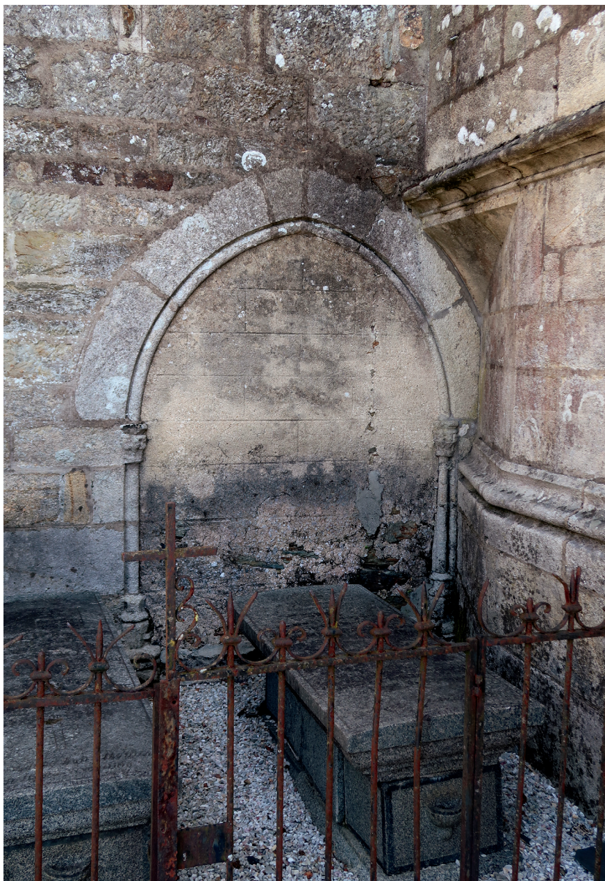
Figure 18 – Le Quillio, église, porte sud murée, ancien accès au chœur (cl. Bernard Bègne, Inventaire du patrimoine culturel © Région Bretagne)
