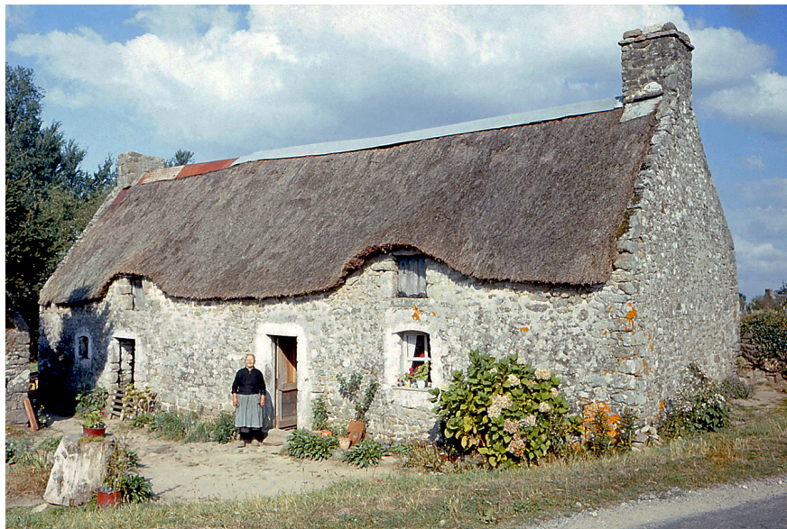
Figure 3 – Mériadec en Plumergat, Morbihan (Arch. dép. Ille-et-Vilaine, fonds Meirion-Jones, 40 Fi 01014, 15 septembre 1972). Remarquez la pente vers l'extrémité de l'étable, qui facilite l'écoulement des eaux.
