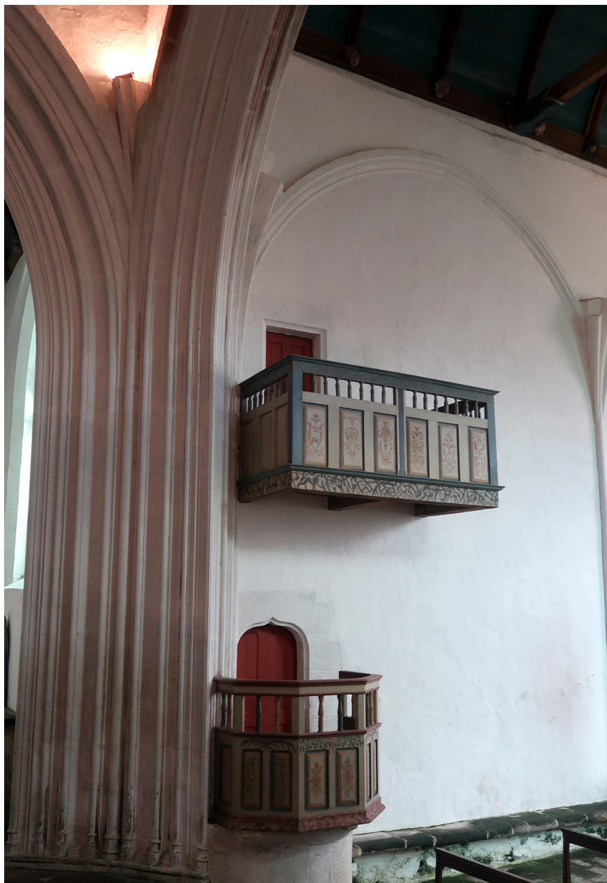
Fig. 3 – Le Faouët, chapelle Saint-Fiacre, vue de deux portes superposées dans le mur nord du chœur (cl. Nathalie Le Pen, service du patrimoine, Roi Morvan communauté)
