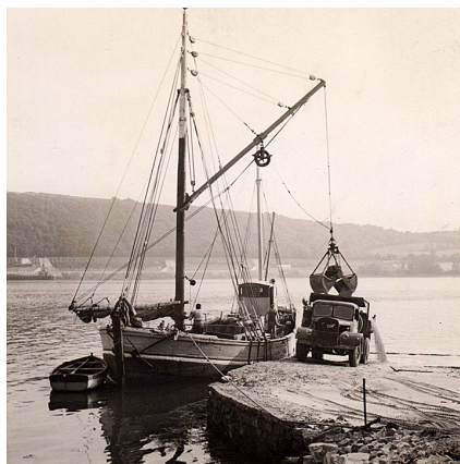
Figure 7 – Penforn, sablier déchargeant du sable à la cale de Penforn pour la construction de la nouvelle abbaye, photographie (Archives de l'abbaye de Landévennec, années 1950)
