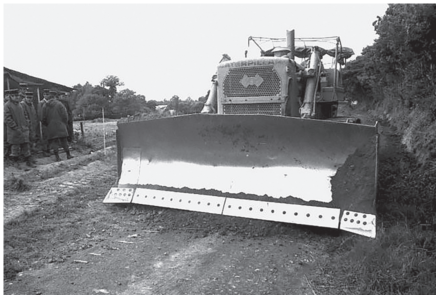
Figure 3 – Trébrivan, bulldozers escortés par les gendarmes mobiles, juin 1975 (cl. Félix Le Garrec)
