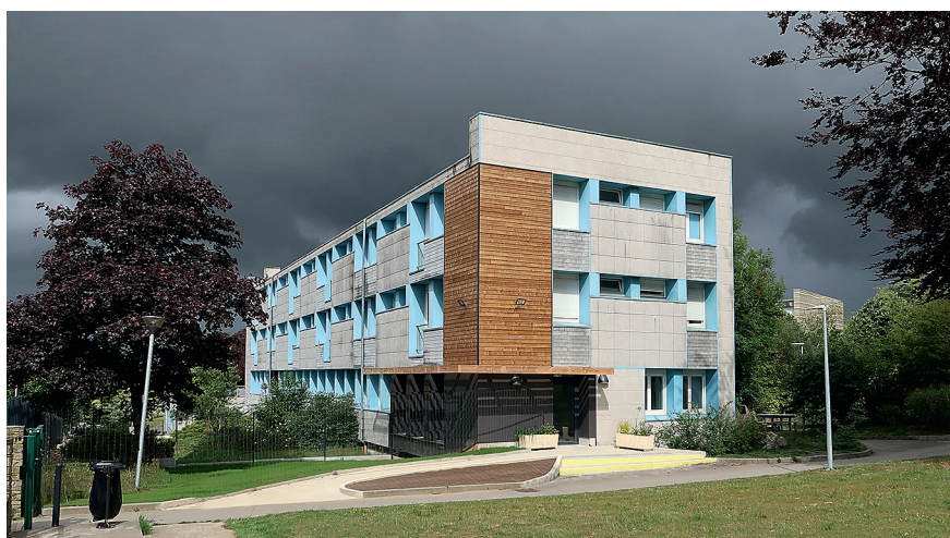
Figure 12 – Carhaix, lycée Paul-Séruzier, vue d'ensemble de l'administration restructurée, prise du sud-est, à l'angle, le nouvel accueil du lycée, septembre 2022 (cl. Thierry Goyet, Inventaire du patrimoine culturel © Région Bretagne)
