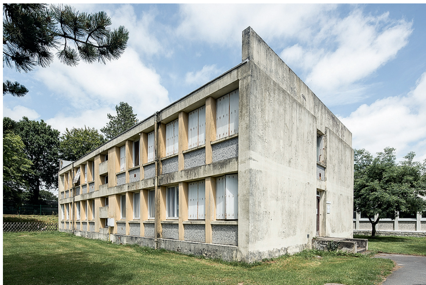
Figure 9 – Carhaix, lycée Paul-Sérusier, vue d'ensemble de l'infirmerie prise du sud-ouest en juillet 2020 (cl. Délia Gaulin-Crespel, Inventaire du patrimoine culturel © Région Bretagne)
