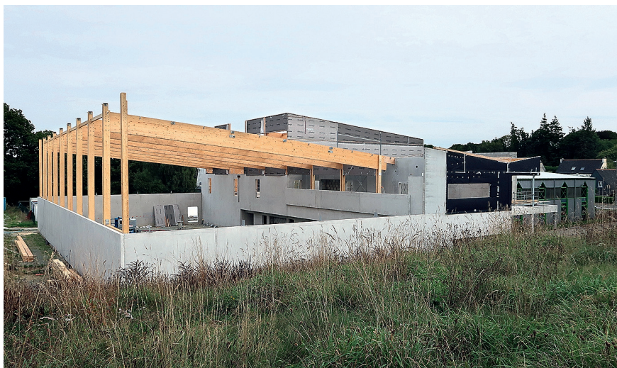
Figure 11 – Carhaix, lycée Paul-Sérusier. Le nouveau gymnase en cours de construction, le 22 septembre 2022. Atelier Cub3, architectes (cl. Thierry Goyet, Inventaire du patrimoine culturel © Région Bretagne)
