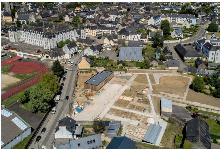
Figure 3 – Carhaix, le chantier de construction de Vorgium en avril 2018 (cl. drone IdeClick)
