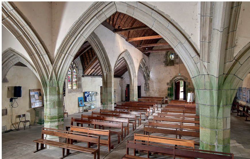
Figure 12 – Spézet, chapelle Notre-Dame-du-Crann, vue oblique de la nef depuis la croisée du transept (IVR53_20222900381NUCA, 2022, cl. Bernard Bègne, Inventaire du patrimoine culturel © Région Bretagne)
