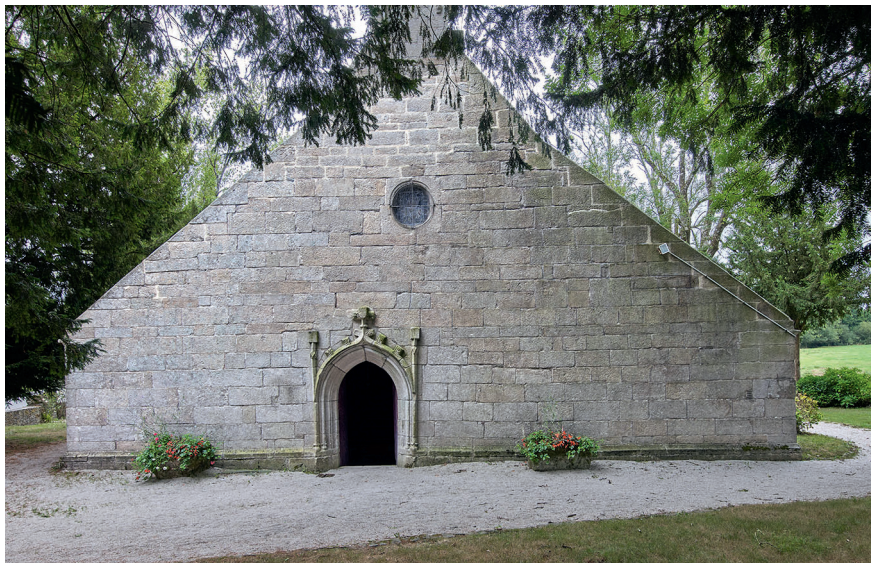
Figure 7 – Spézet, chapelle Notre-Dame-du-Crann, façade ouest, vue générale (IVR53_20222900388NUCA, 2022, cl. Bernard Bègne, Inventaire du patrimoine culturel © Région Bretagne)
