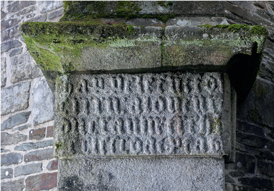
Figure 3 – Spézet, chapelle Notre-Dame-du-Crann, façade nord, détail de l’inscription portée sur le contrefort d’angle nord-ouest du croisillon (IVR53_20222900404NUCA, 2022, cl. Bernard Bègne, Inventaire du patrimoine culturel © Région Bretagne)
