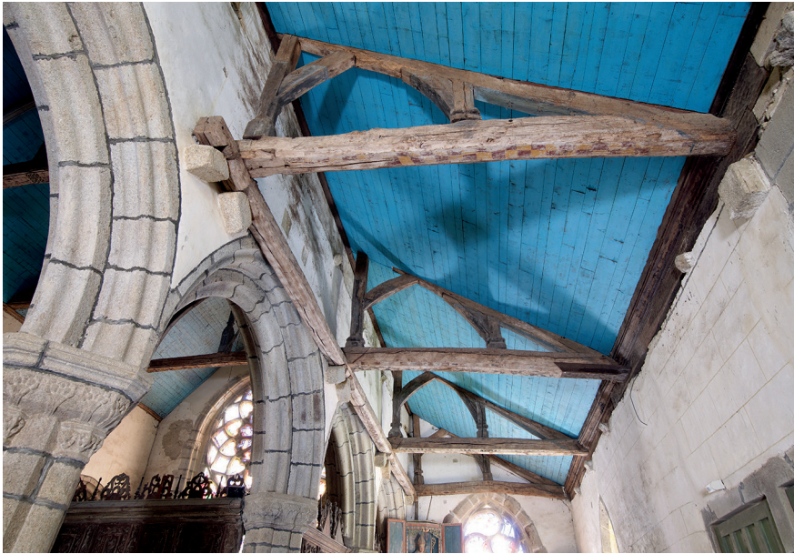
Figure 6 – Plonévez-du-Faou, chapelle Saint-Herbot, charpente du collatéral sud (cl. Bernard Bègne, Inventaire du patrimoine culturel © Région Bretagne)
